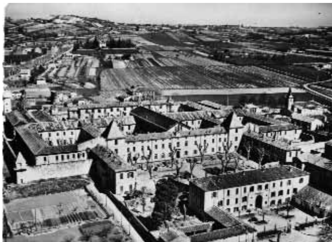
PHOTO AÉRIENNE DE LA CENTRALE D'EYSSES.
