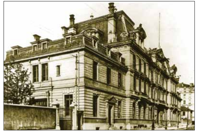
L'ÉCOLE DU SERVICE DE SANTÉ MILITAIRE, AVENUE BERTHELOT À LYON, AVANT LE BOMBARDEMENT ALLIÉ DE MAI 1944. LE SIPO-SD (GESTAPO) DE LYON EN OCCUPAIT LES LOCAUX DEPUIS LE PRINTEMPS 1943. FRANCIS ANDRÉ ET SON ÉQUIPE PRATIQUAIENT LÀ INTERROGATOIRES ET TORTURES.
